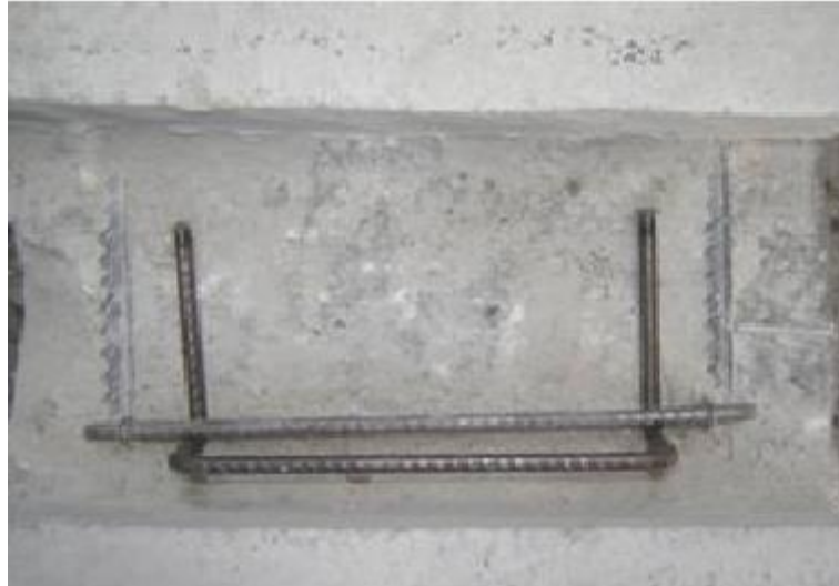
Figura 16 – Colocação dos conectores do reforço, NASCIMENTO (2009)
