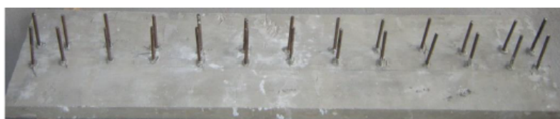
FIGURA 9: Conectores de cisalhamento fixados na mesa com adesivo estrutural.
