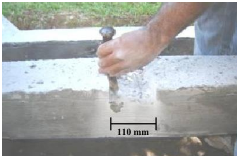
Figura 15 – Execução dos sulcos para colocação dos conectores, NASCIMENTO (2009)
