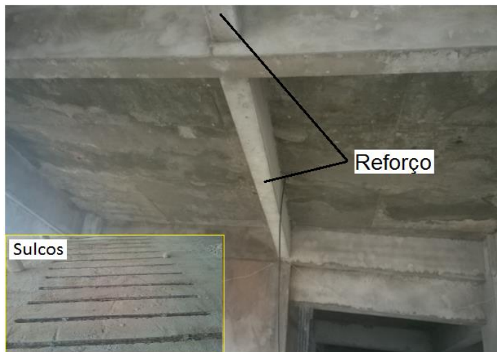
Figura 44 – Viga concretada e os sulcos com ferros negativos
