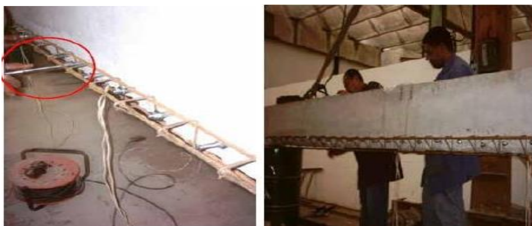
Figura 21 – Operação de fixação dos conectores de cisalhamento nas vigas, SANTOS (2006)
