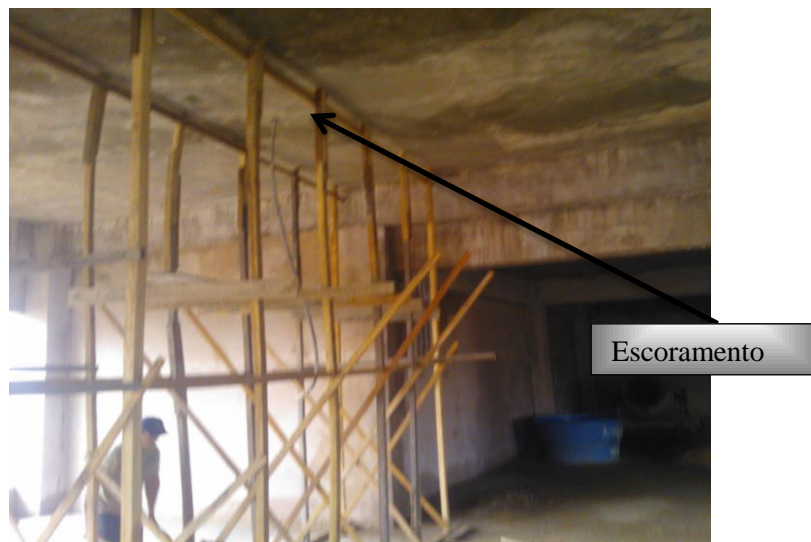
Figura 39 – Escoramento da Viga de Reforço
