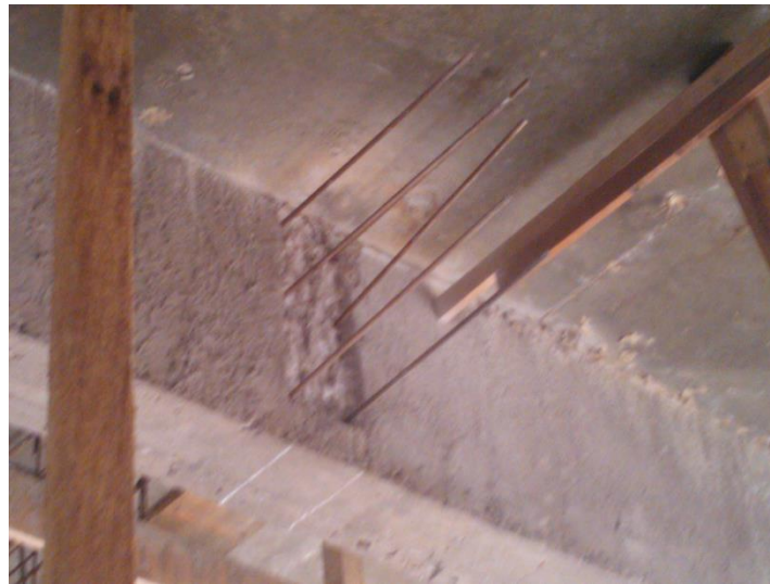
Figura 38 – Furo na Viga para Engastar a Viga de Reforço
