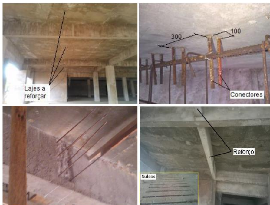
FIGURA 16: Aplicação da técnica de reforço de laje com vigas adicionais. FONTE: Próprio autor (2015).
