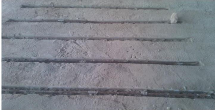
Figura 43 – Sulcos com ferros negativos fixados com sikadur 32
