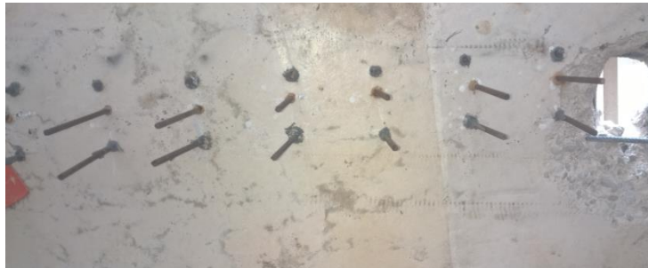
Figura 41 – Conectores fixados na laje
