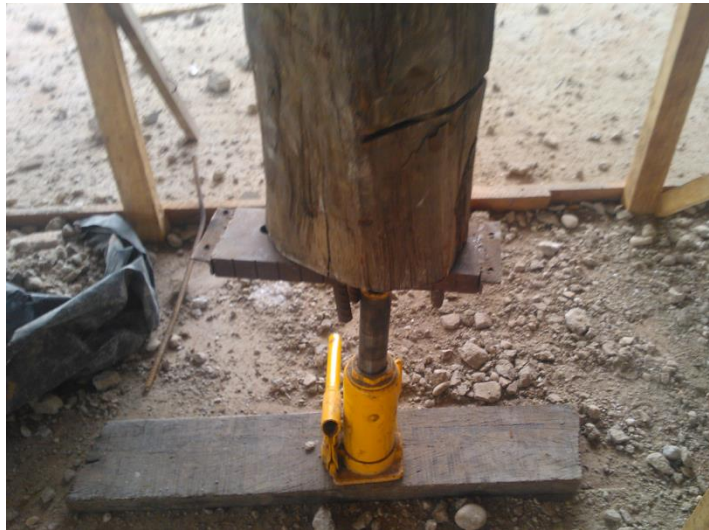
Figura 40 – Levante da laje com macaco hidráulico
