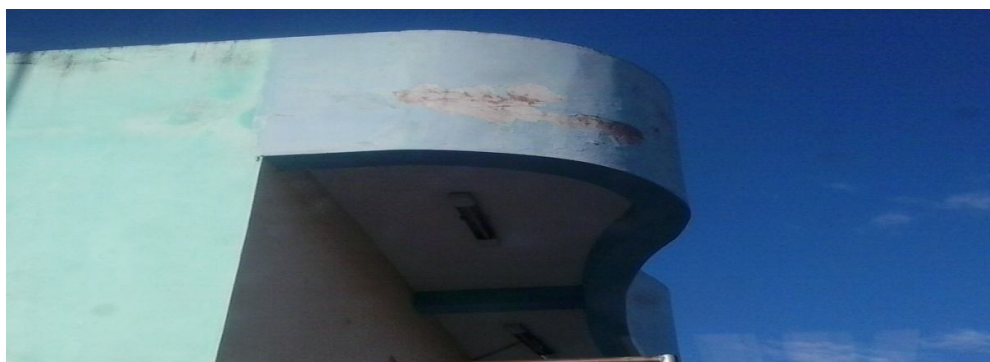
Figura 1.2 - Estrutura danificada por ação de intempéries – traço não controlado.
