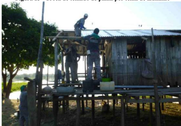
Figura 13 - Troca de telhado de palha por telha de alumínio
