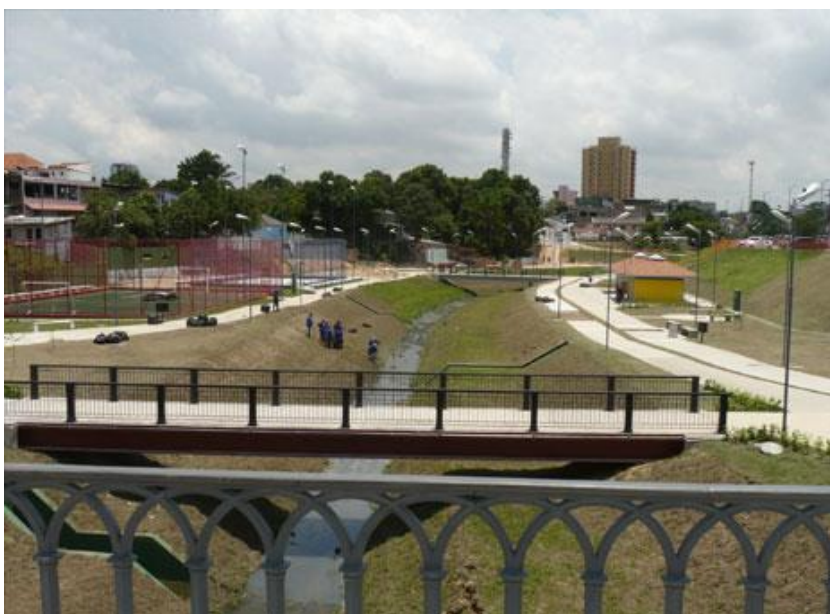
Figura 10 –Igarapé do Bittencourt após da intervenção do PROSAMIM I Fonte: http://www.senadoreduardobraga.com.br/
