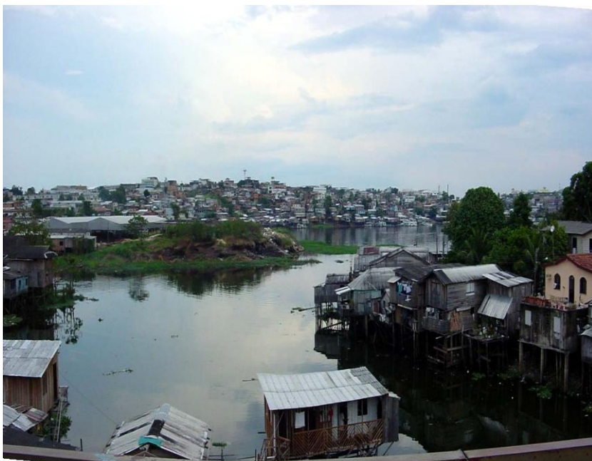
Figura 7 –Igarapé do Quarenta antes da intervenção do PROSAMIM I Fonte: www.hardmob.com.br
