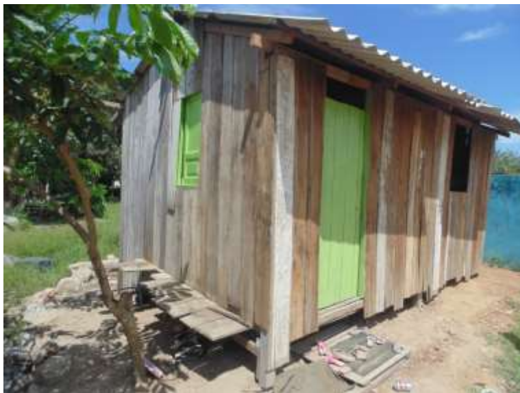
Figura 5 : Tipo de residência verificada na Vila de Lindóia – AM, em madeira
