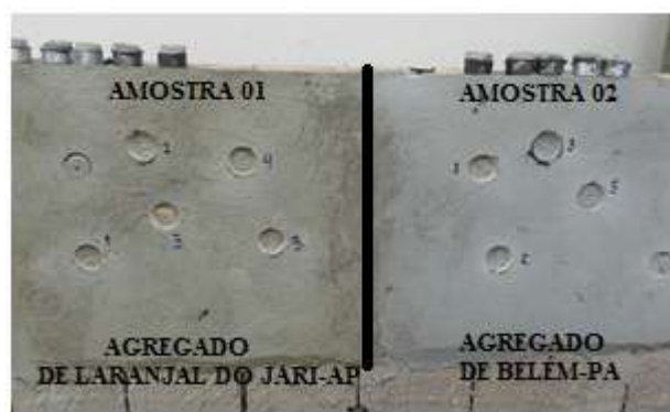
Figura 18 – Amostra da parede após o ensaio.
