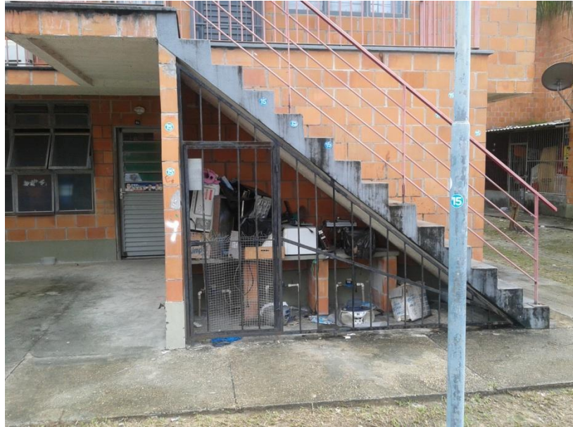
Foto: 4.4.12 Área de medidor de água. Fonte: Karoline Lima, (2015)
