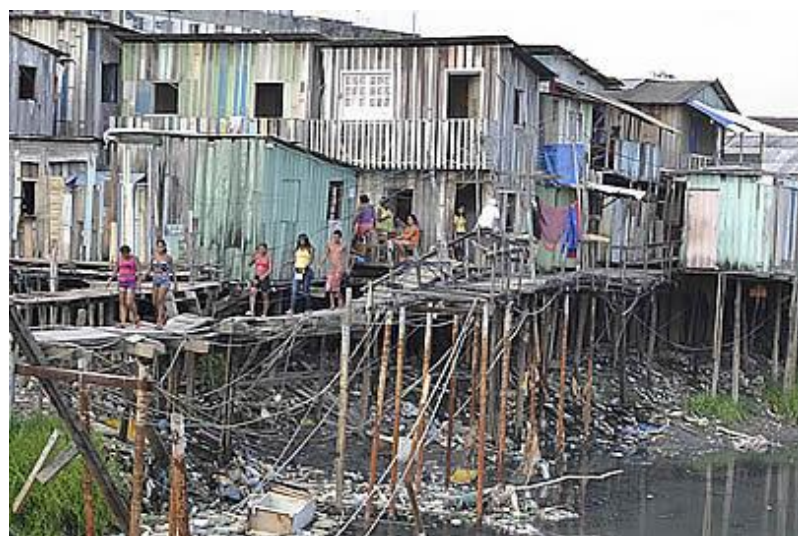
Figura 4.2.5: Igarapé de Manaus antes do projeto PROSAMIM
