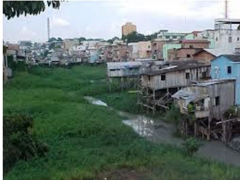
Figura 4.2.4: Igarapé de Manaus antes da obra do PROSAMIM
