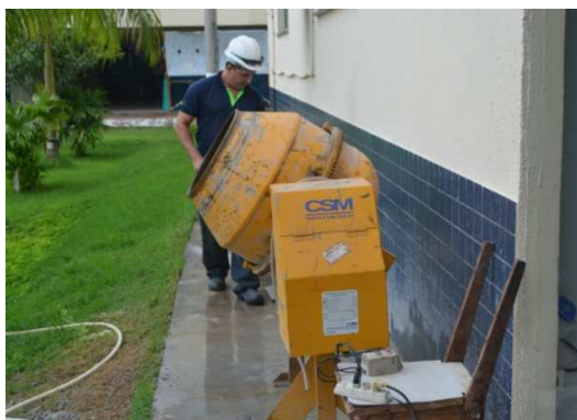
Figura 30 - Betoneira utilizada na confecção do traço experimental
