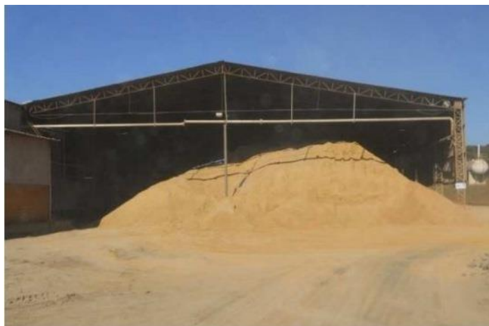
Figura 3 – Estocagem em galpões cobertos (SANTIS, 2012)
