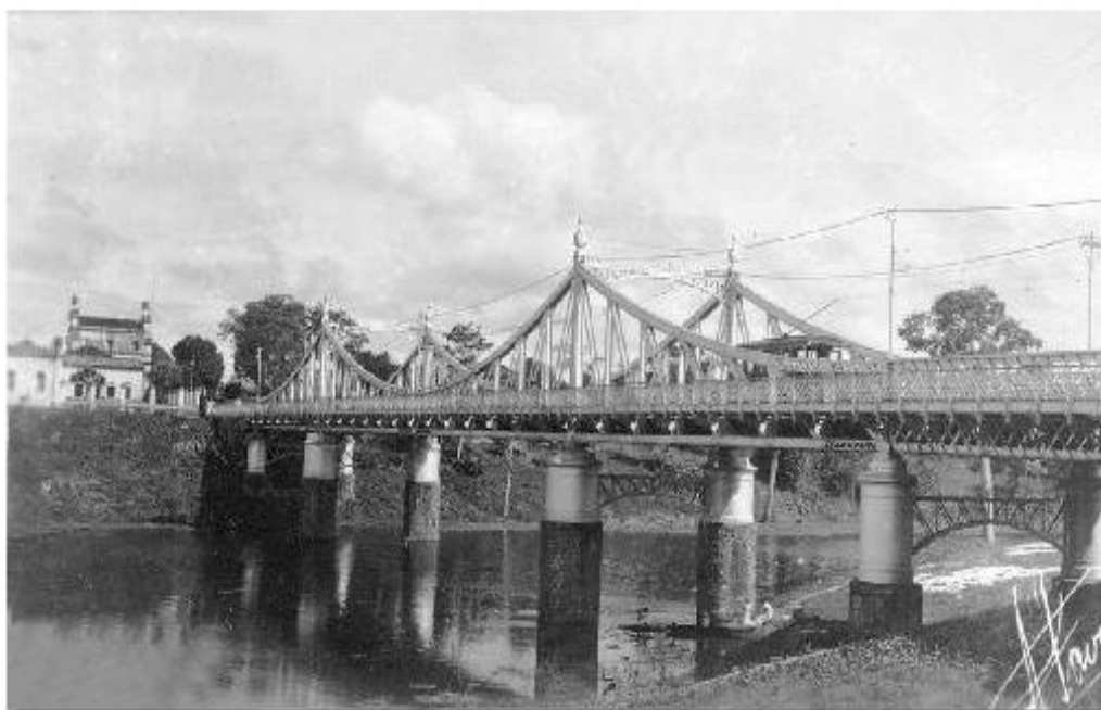
Figura 3.9: Ponte Metálica Eduardo Ribeiro - Aquela que fica na Avenida Sete de Setembro e que foi recentemente reformada. Olhem como o rio era limpo e bonito.
