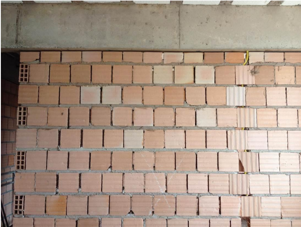
Figura 24 – Encunhamento de alvenaria com argamassa convencional com argamassa expansiva
