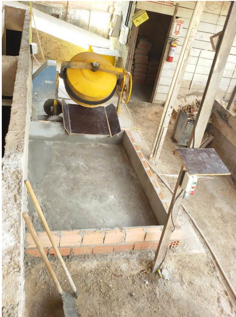
Figura 4 – Central de argamassa da obra
