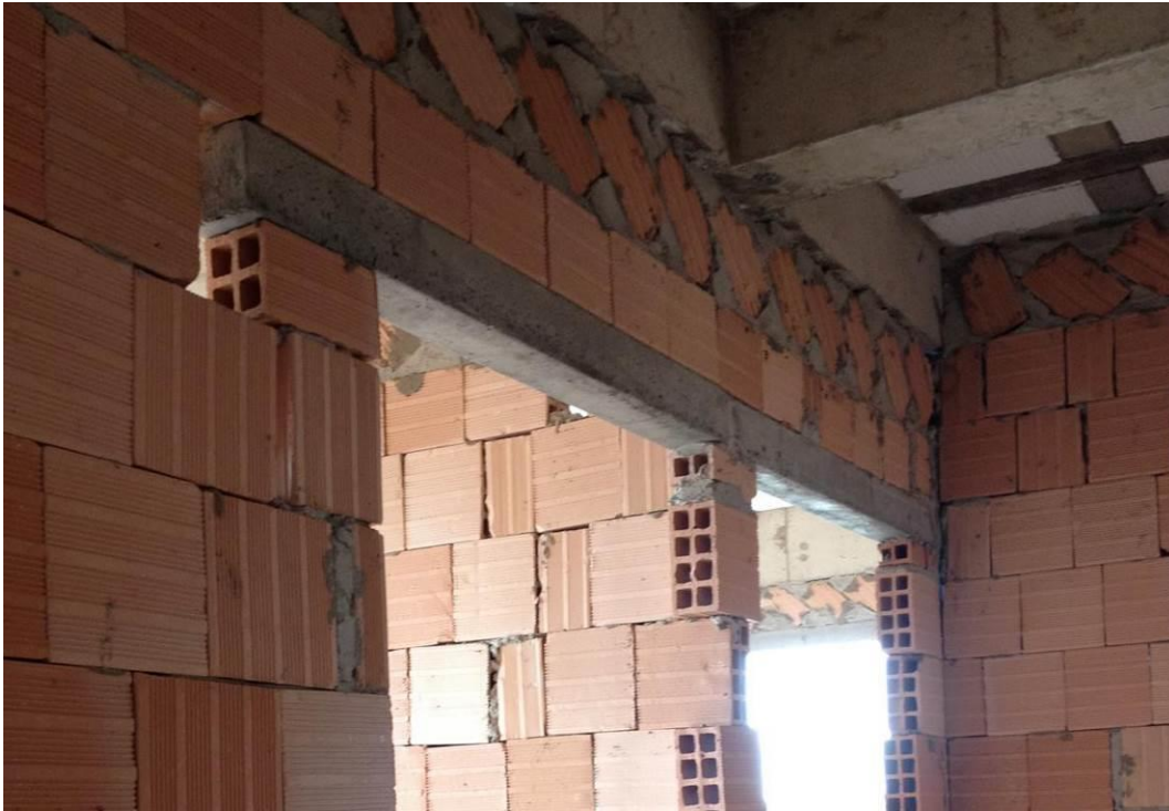
Figura 25 – Encunhamento de alvenaria com argamassa pronta utilizando tijolo a 45 graus
