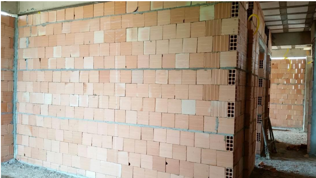
Figura 21 – Melhoras no nivelamento da alvenaria com a adoção de novos procedimentos
