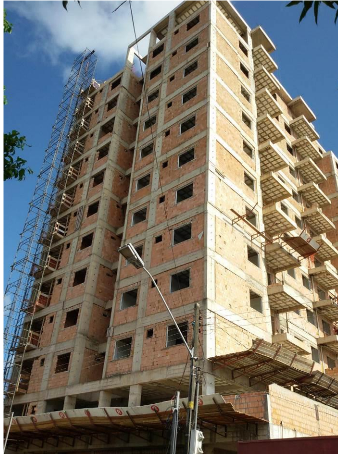
Figura 3 – Fachada frontal da obra em Novembro de 2014
