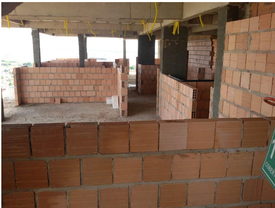
Figura 17 - Nivelamento das fiadas com argamassa convencional
