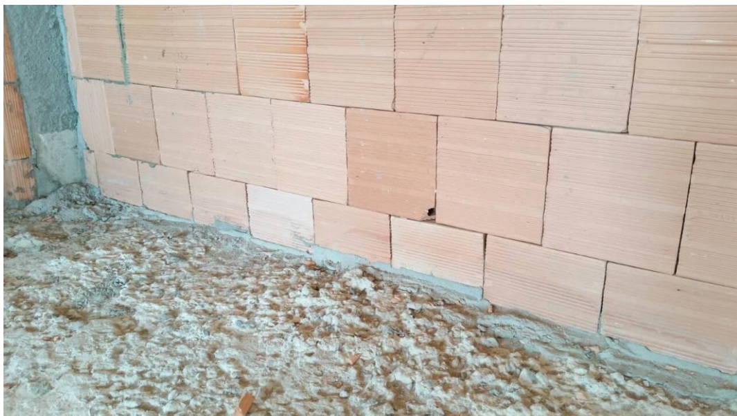
Figura 22 – Ajuste da altura das fiadas com auxílio da fiada de marcação
