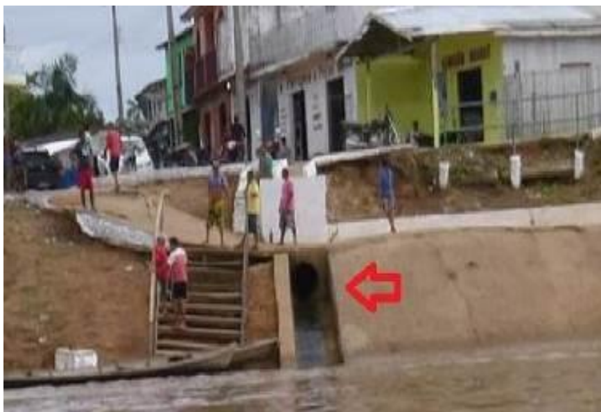
Figura 22: A orla do município com tubulação do esgoto doméstico.
