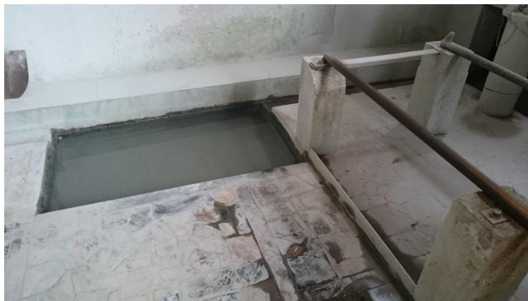
Figura 16 - Tanque de decantação de lama proveniente das máquinas de corte.
