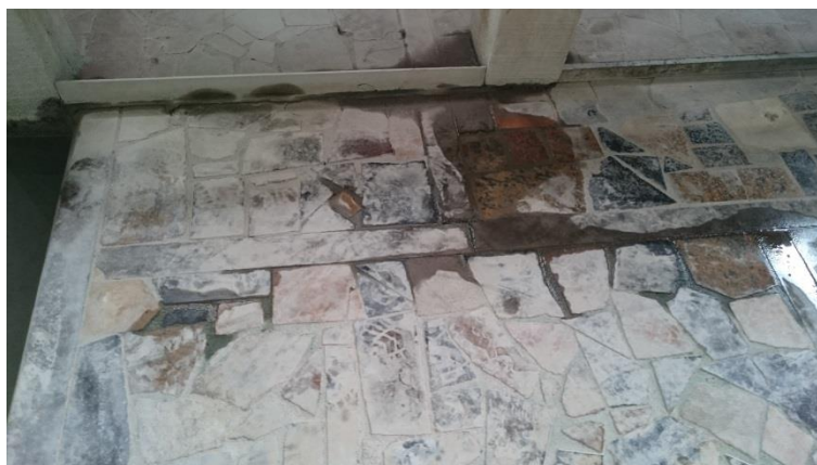
Figura 13 - Área com resquícios da lama seca contendo alto teor de sílica.
