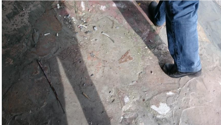
Figura 15 - Lama proveniente dos processos de acabamento e corte.
