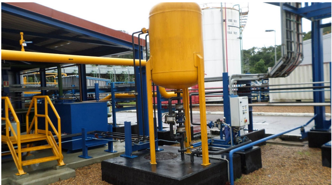
Figura 4.9: Vaso que recolhe os resíduos líquidos do Gás Natural (Manauara, 2015)
