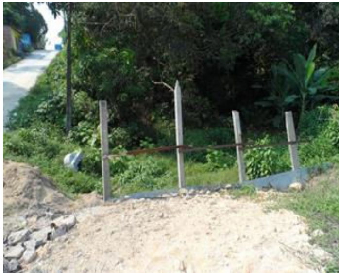
Figura 4.26: Igarapé da comunidade São João assoreamento para caminho (Igarapé, 2013)
