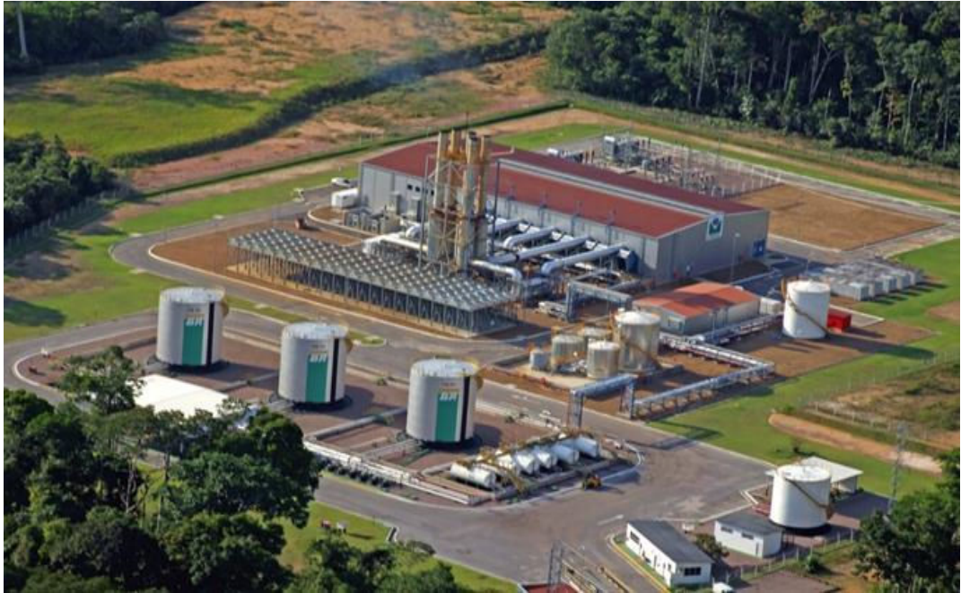
Figura 4.2: Usina Termoelétrica Manauara (UTE Manauara, 2010)
