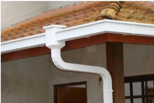
Figura 13 - Calha do tipo beiral. Fonte: helpin, 2012.
