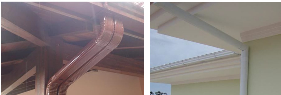
Figura 18 - Condutores retangulares e cilíndricos. Fonte: Belleflux Calhas, 2009.
