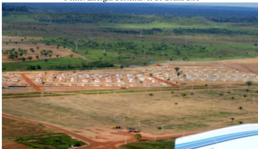
Figura 3.9 Vista aérea da Infraestrutura da Nova Vila Mutum Paraná. Fonte: Energia Sustentável do Brasil S.A
