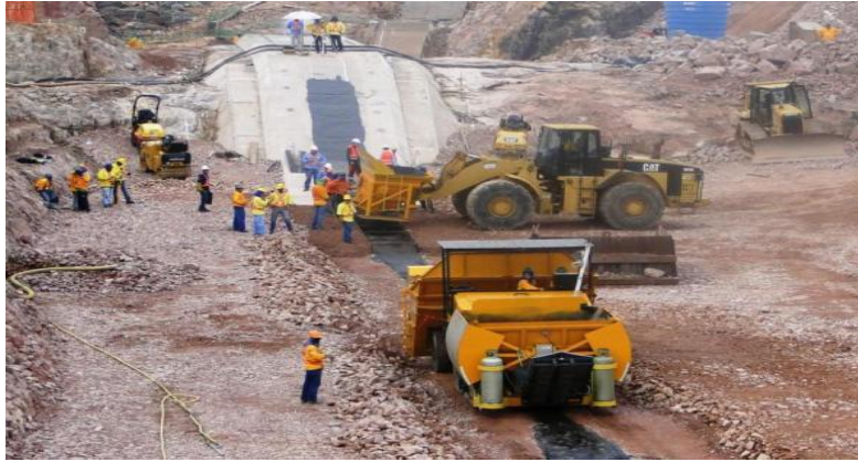
Figura 1.12 Execução no núcleo asfáltico Fonte: RAMALHO, Marcelo Carlos. et al (2013)
