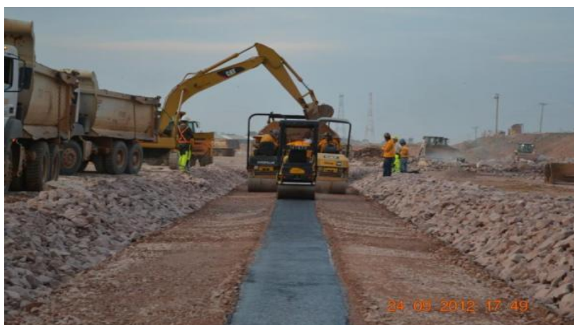
Figura 1.15 Compactação simultânea do núcleo asfáltico Fonte: RAMALHO, Marcelo Carlos. et al (2013)
