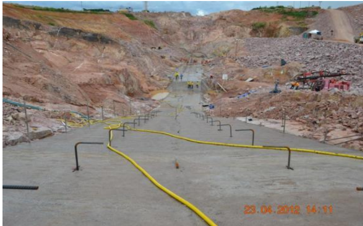
Figura 1.9 Concretagem para regularização da fundação Fonte: RAMALHO, Marcelo Carlos. et al (2013)
