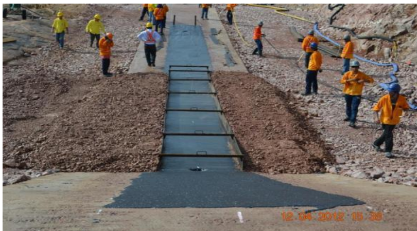
Figura 1.14 Lançamentos manuais para o estabelecimento de uma base horizontal para posterior uso de máquina de pavimentação. Fonte: RAMALHO, Marcelo Carlos. et al (2013)
