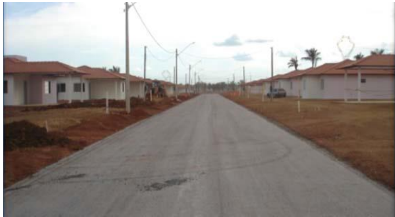
Figura 3.10 Pavimentação das ruas da Nova Vila Mutum Paraná. Fonte: Energia Sustentável do Brasil S.A
