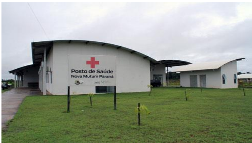
Figura 3.8 Posto de Saúde construído da Nova Vila Mutum Paraná. Fonte: Energia Sustentável do Brasil S.A
