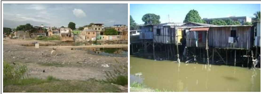
Figura 2.3: Palafitas/moradias dos ribeirinhos no Igarapé do Quarenta – Bairro Morro da Liberdade Fonte: Prosamim (2013).
