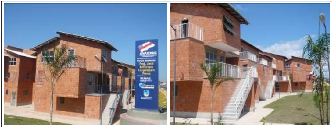
Figura 2.4: Unidades Habitacionais construídas no Igarapé do Quarenta – Prosamim Fonte: Prosamim, (2013).
