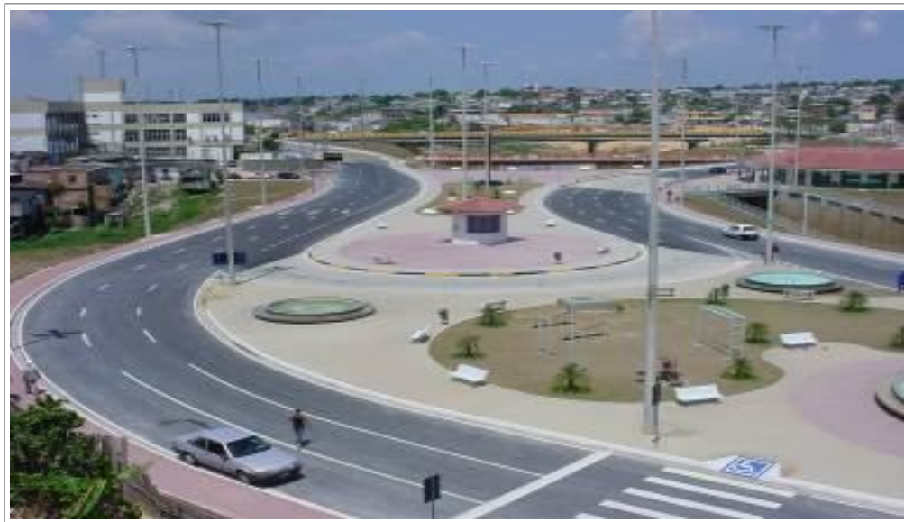
Figura 5.4: Prosamim II - Igarapés Quarenta – Morro da Liberdade Fonte: Prosamim (2013).
