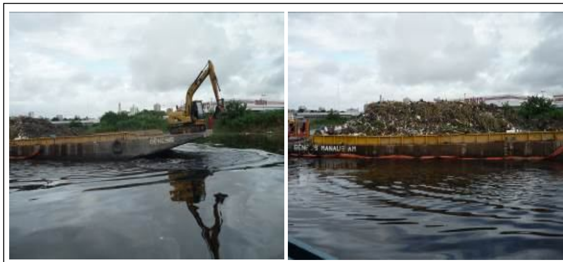
Figura 4.4: Retirada do lixo jogado no igarapé Fonte: Prosamim (2013).
