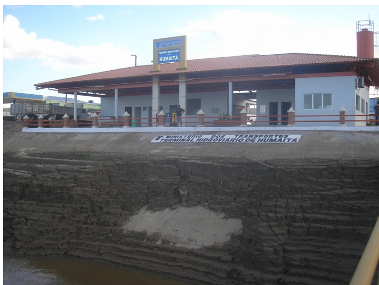
Figura 12: Acúmulo de materiais nas encostas de Humaitá. Fonte: IP4, 2012.
