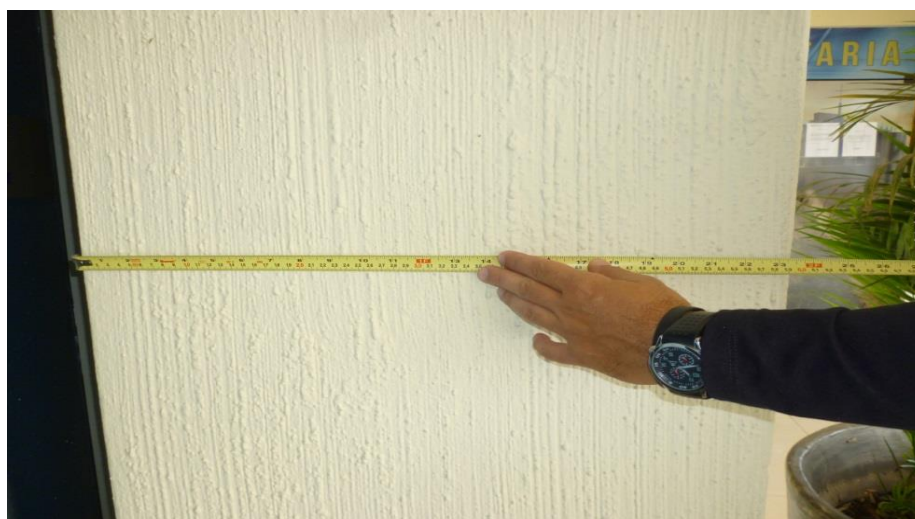
Figura 15 – Medição da parede externa
