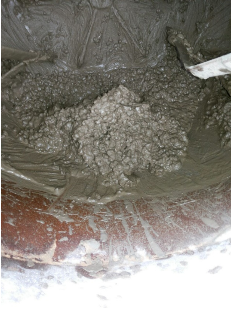
Figura 3.13 - concreto laterítico na betoneira
