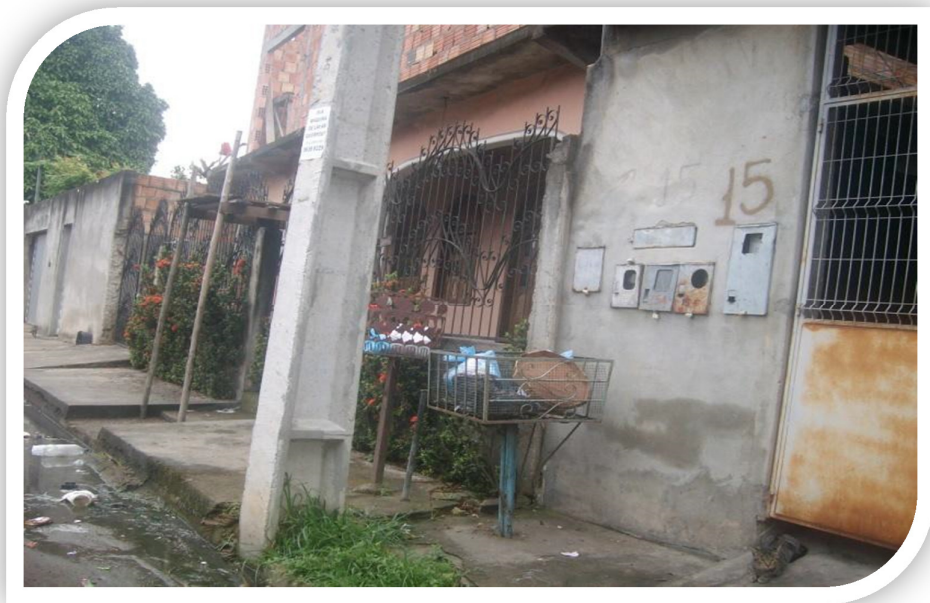
Figura 4.6 – Lixeira inapropriada na Rua João Bosco Bornier, no bairro Zumbi dos Palmares (Pesquisa de campo, 2013)
