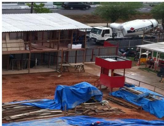
**Figura 3.4:** Madeiras de demolição utilizadas na construção de um novo canteiro de obras
