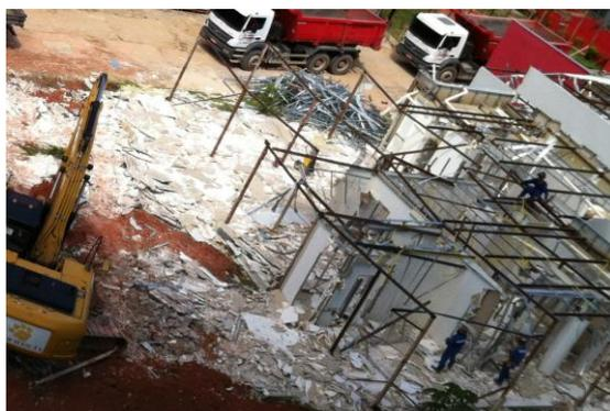
**Figura 3.9:** Demolição do stand de vendas e a remoção do gesso acartonado e placas do gesso do forro.
