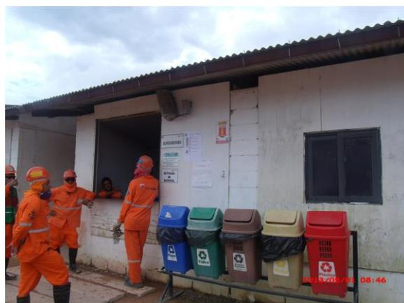
**Figura 3.3:** Depósito de segregação dos resíduos em um canteiro de obras
