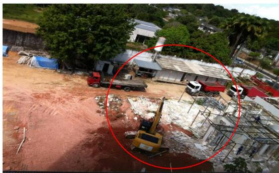
**Figura 3.5:** Restos de madeiras, sobras cerâmicas e madeiras removidas do canteiro
