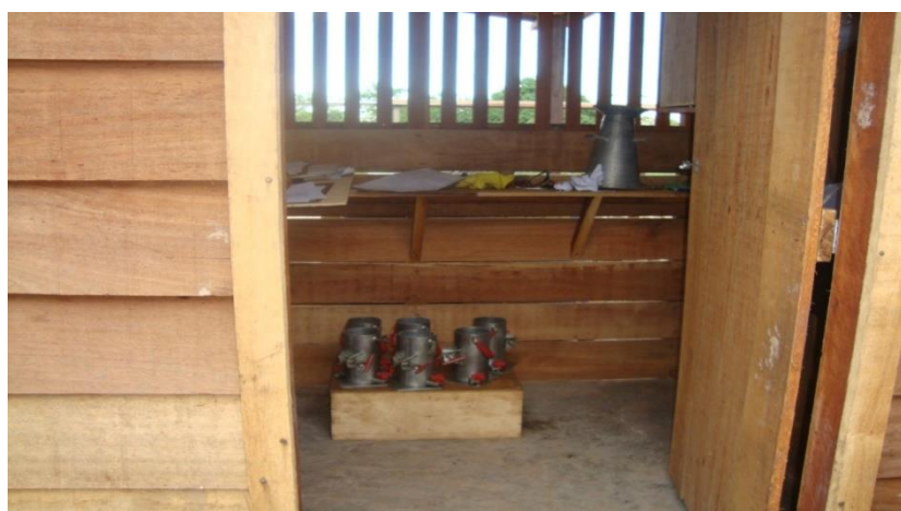
Figura 23 – Sala de controle tecnológico
