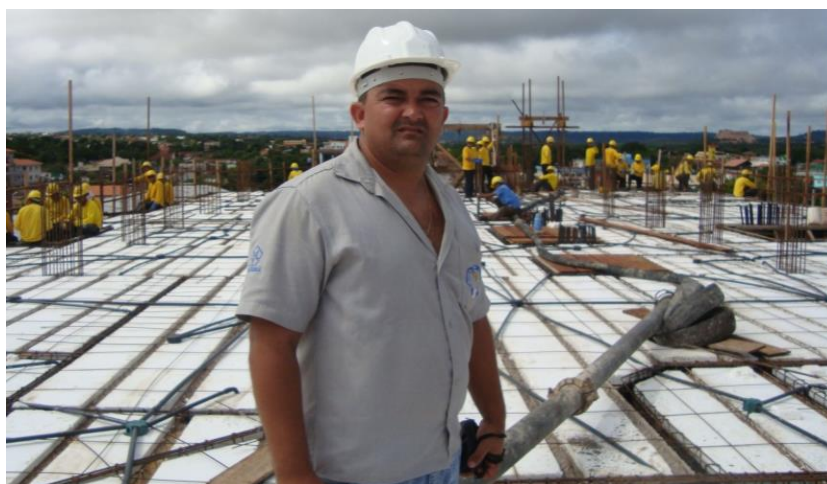
Figura 42 – Equipe de concretagem..
