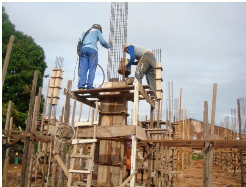
Figura 40 – Concretagem de pilares.
