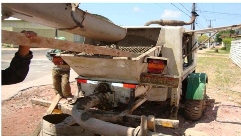
Figura 17 – Bomba de lançamento.
