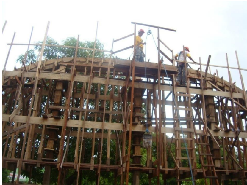
Figura 39 – Concretagem de vigas.
