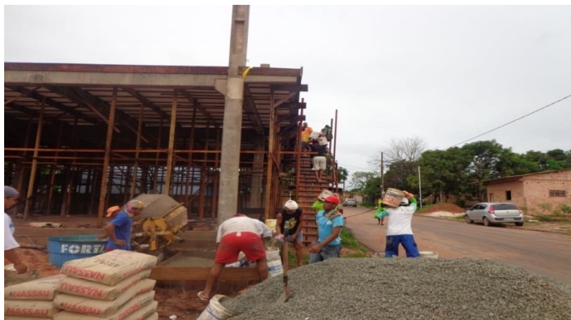
Figura 10 – Canteiro de obra
