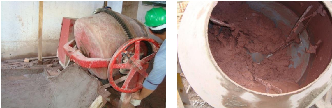
Figura 20 – Homogeneização em betoneira.
