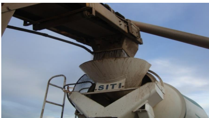
Figura 15 – Tubo de Lançamento
