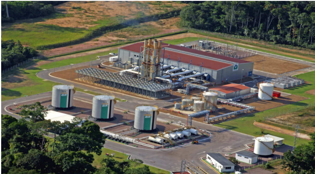
Figura 2.2: Ilustrativo da Usina Termoelétrica Manauara Fonte: UTE Manauara (2013)
