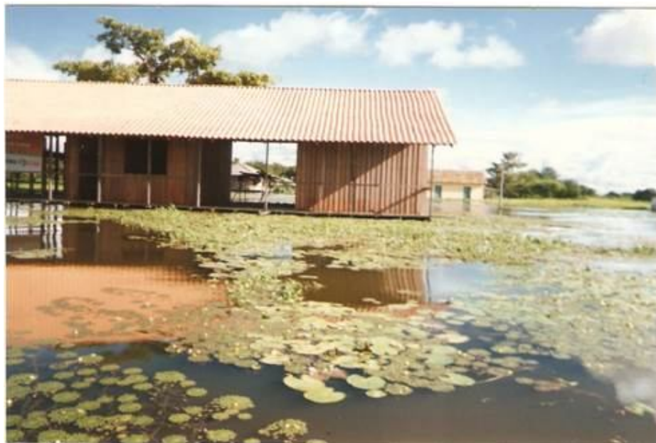
Figura 2.3 – Escola prestes a sofrer alagamento. FONTE: Carvalho J. Comércio de Material Elétrico e Serviços, 2013
