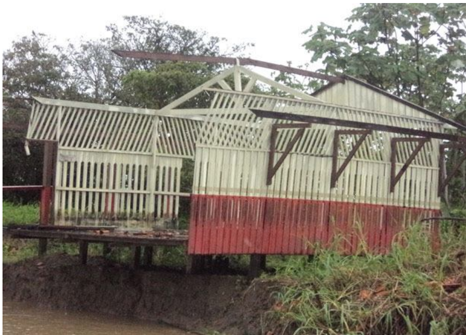
Figura 03 – Escola Tiradentes na margem do rio. FONTE: Notapajos, 2011
