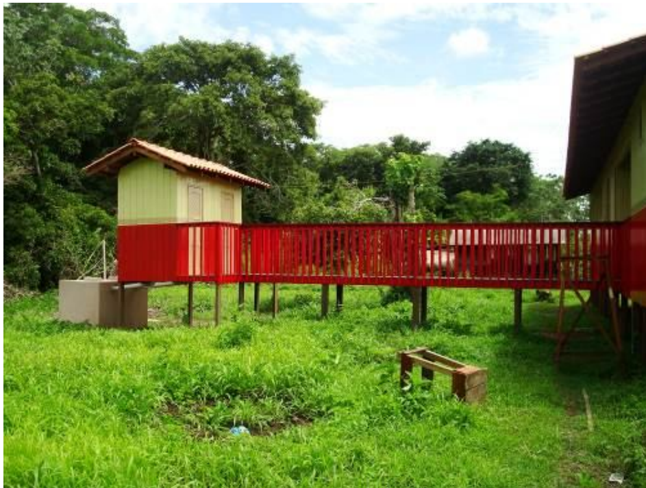
Anexo A.2 - Escola Santa Terezinha FONTE: IPAM,2011.
