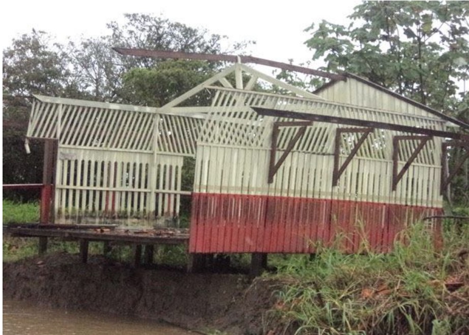
Figura 2.2 – Escola Tiradentes na margem do rio. FONTE: Notapajos, 2011
