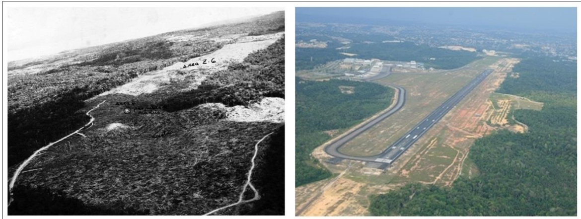
B - Ano de 1971, desmatamento para início das obras do SBEG em área florestal. Fonte: acervo Infraero.
