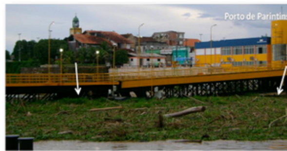
Figura 3 - Acúmulo de materiais orgânicos no Porto de Parintins/AM
