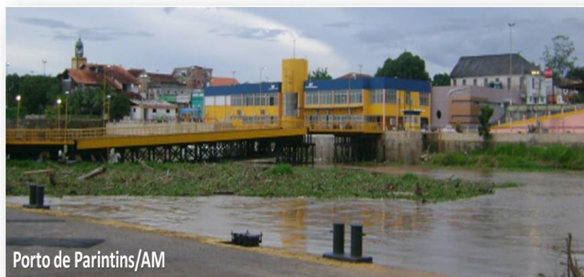
Figura 53: Flutuante do Porto de Parintins/AM. Fonte: DOC, 2011.
