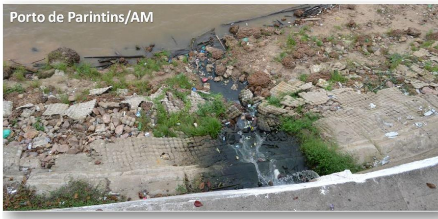
Figura 58: Lançamento de efluentes (erosão) – Porto de Parintins/AM. Fonte: SMA/DPatr.
