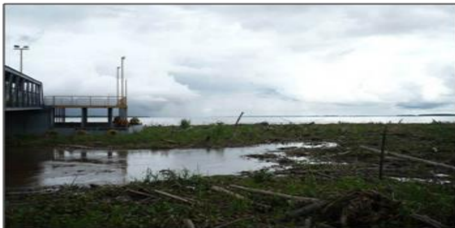
Figura 13: Material acumulado nos flutuantes intermediários, cabos e flutuante principal. Fonte: primária
