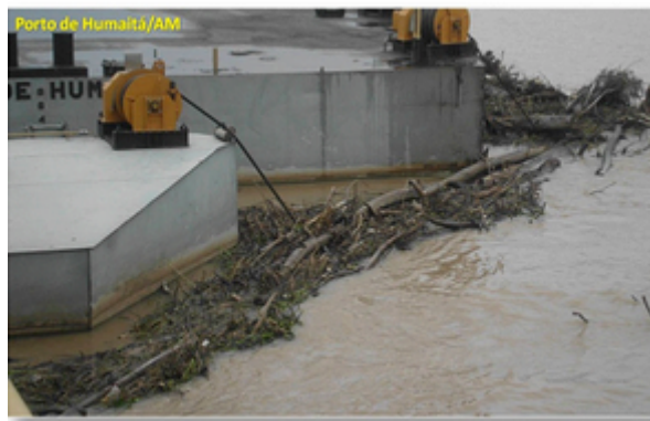
Figura 2 - Acúmulo de material vegetal nos cabos – Porto de Humaitá/AM Fonte: Adm. Porto Humaitá.
