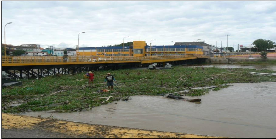
Figura 68: Terminal de Parintins - Condição de enchente. Fonte IP4, 2011.
