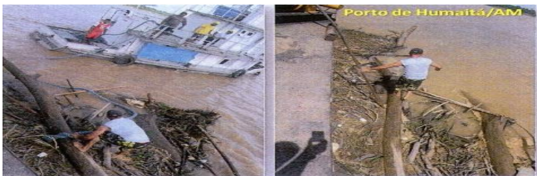
Figura 67: Retirada manual do material vegetal no Terminal de Humaitá/AM.
