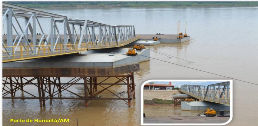
Figura 33: Flutuantes e sistema de ancoragem no Porto de Humaitá/AM. Fonte: DOC.
