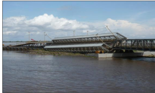
Figura 66: Pontes Metálicas do Terminal de Manacapuru/AM foram deslocadas devido ao acúmulo de Matérias.
