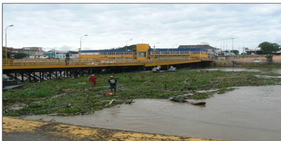
Figura 26: Terminal portuário do município de Parintins – AM em condição de enchente. Fonte: IP4, 2011.
