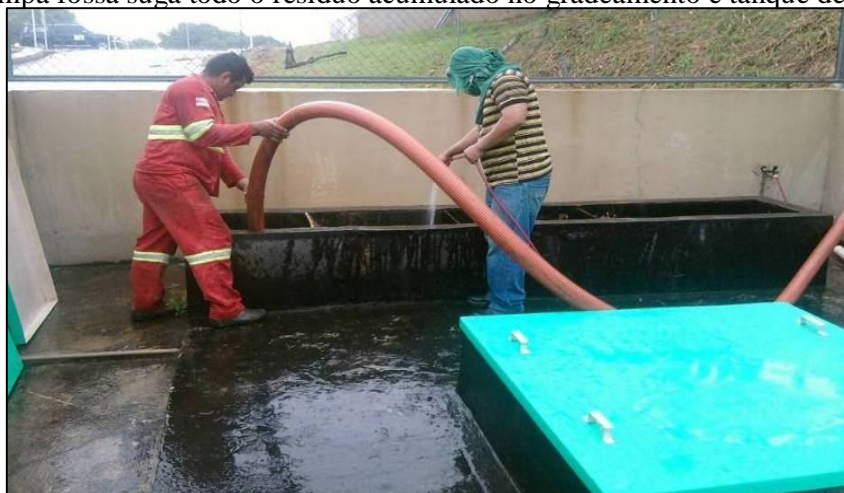
Figura 4.13 – Limpeza do gradeamento Fonte: MARTINS, A. G. (2013).
