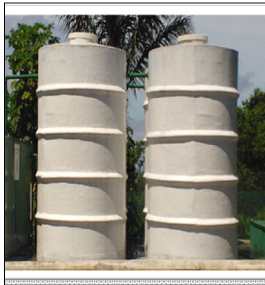
Figura 4.8 – Tanque de sedimentação/Equalização. Fonte: MARTINS, A. G. (2013).
