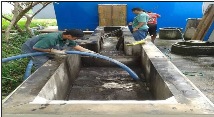
Figura 4.16 – Remoção da gordura. Fonte: MARTINS, A. G. (2013).
