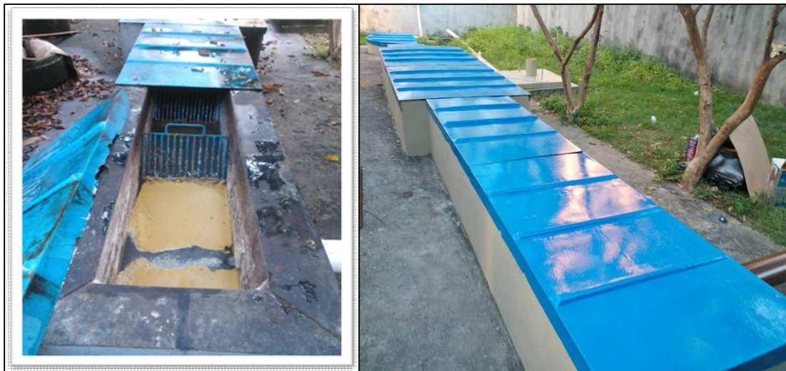
Figura 4.5 - Gradeamento Fonte: MARTINS, A. G. (2013).
