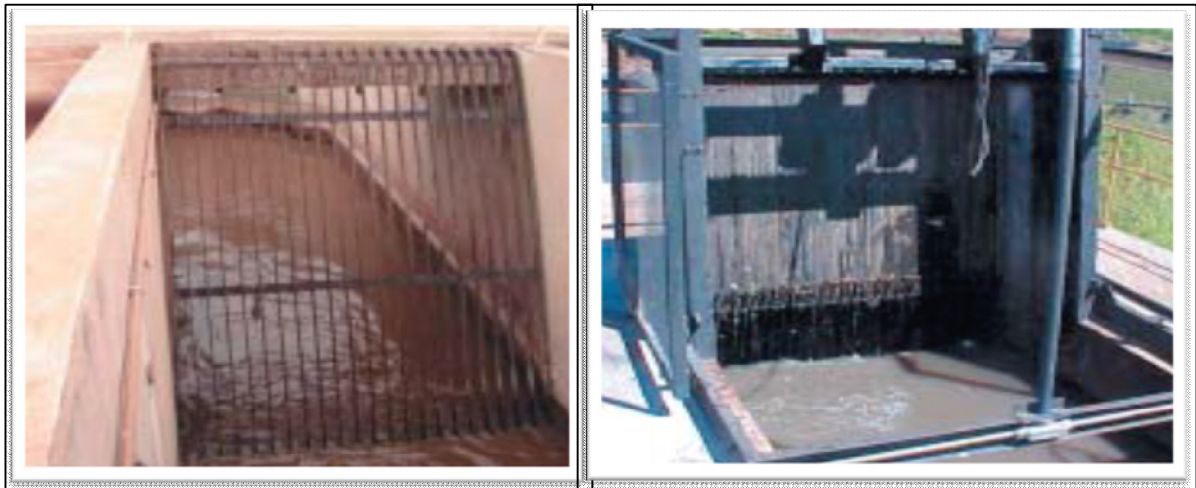
Figura 2.1 - Grade de limpeza manual e Fonte: FEAM (2006).
