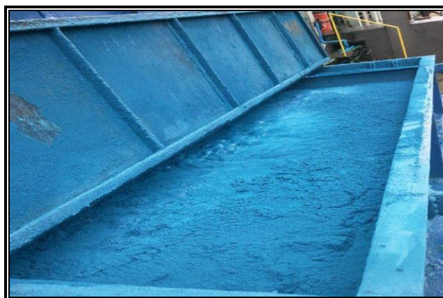
Figura 4- Tanque de armazenamento da Borra de Tinta.
